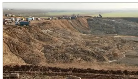
Une vue du chantier (DR)
