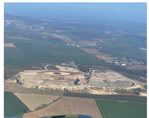
Les Yeux du Ciel , vue du ciel montrant l'œil Ouest en cours de réalisation, 2023, Villeneuve-sous-Dammartin, France © Droits réservés
